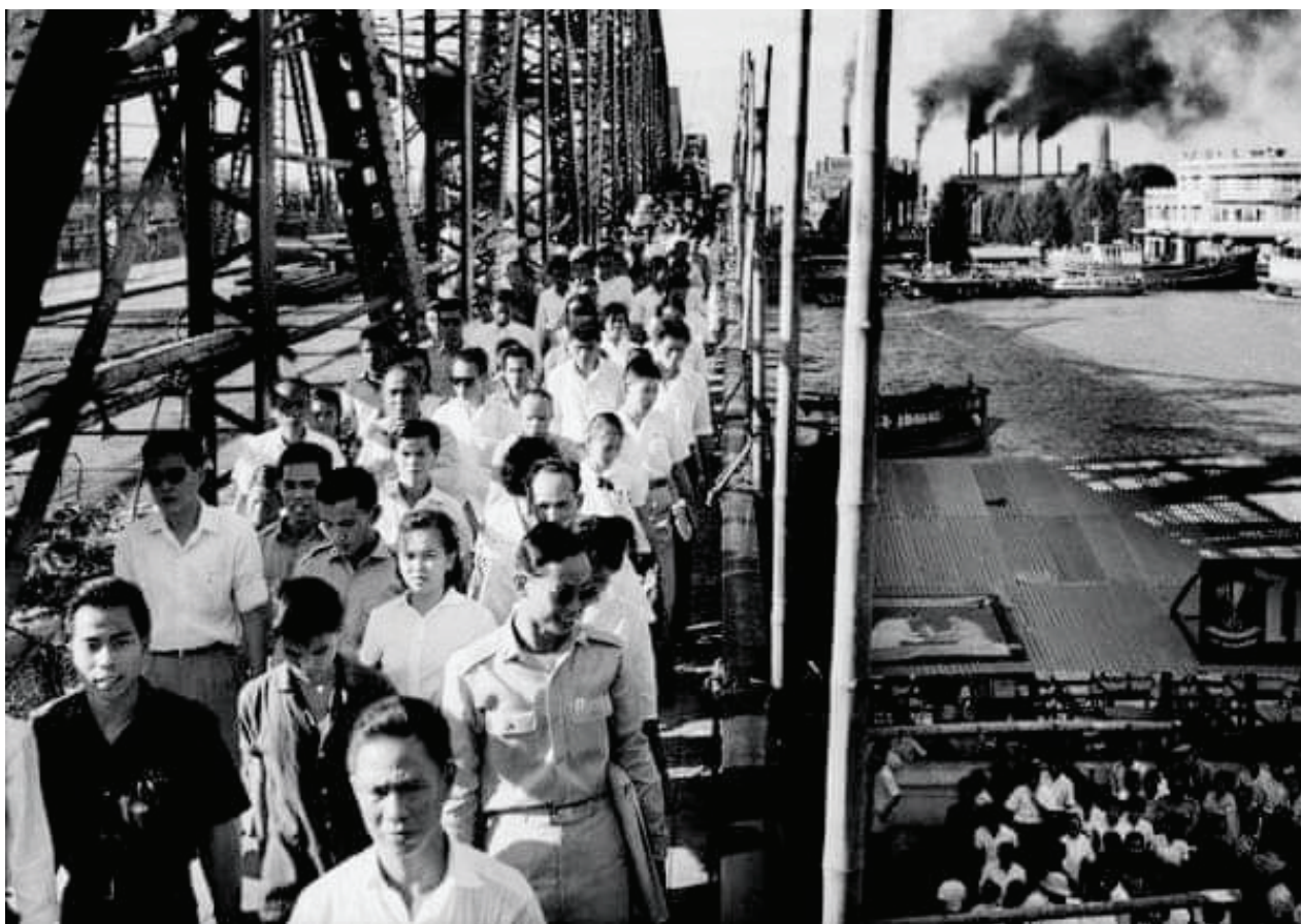
โรงไฟฟ้าวัดเลียบ ถ่ายจากสะพานพุทธฯ ปีพ.ศ.2501 Wat Liab Power Plant (viewed from Memorial Bridge) 1958
